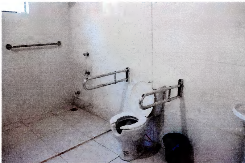
Imagen 5. Sanitario con barras para pcd.
